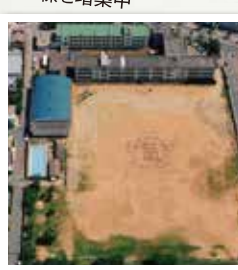
校庭の拡張工事が完了し、 現在の広さのグラウンドに!
